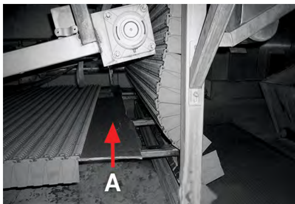
A リターン側走行路より高く置いたフラット素材
